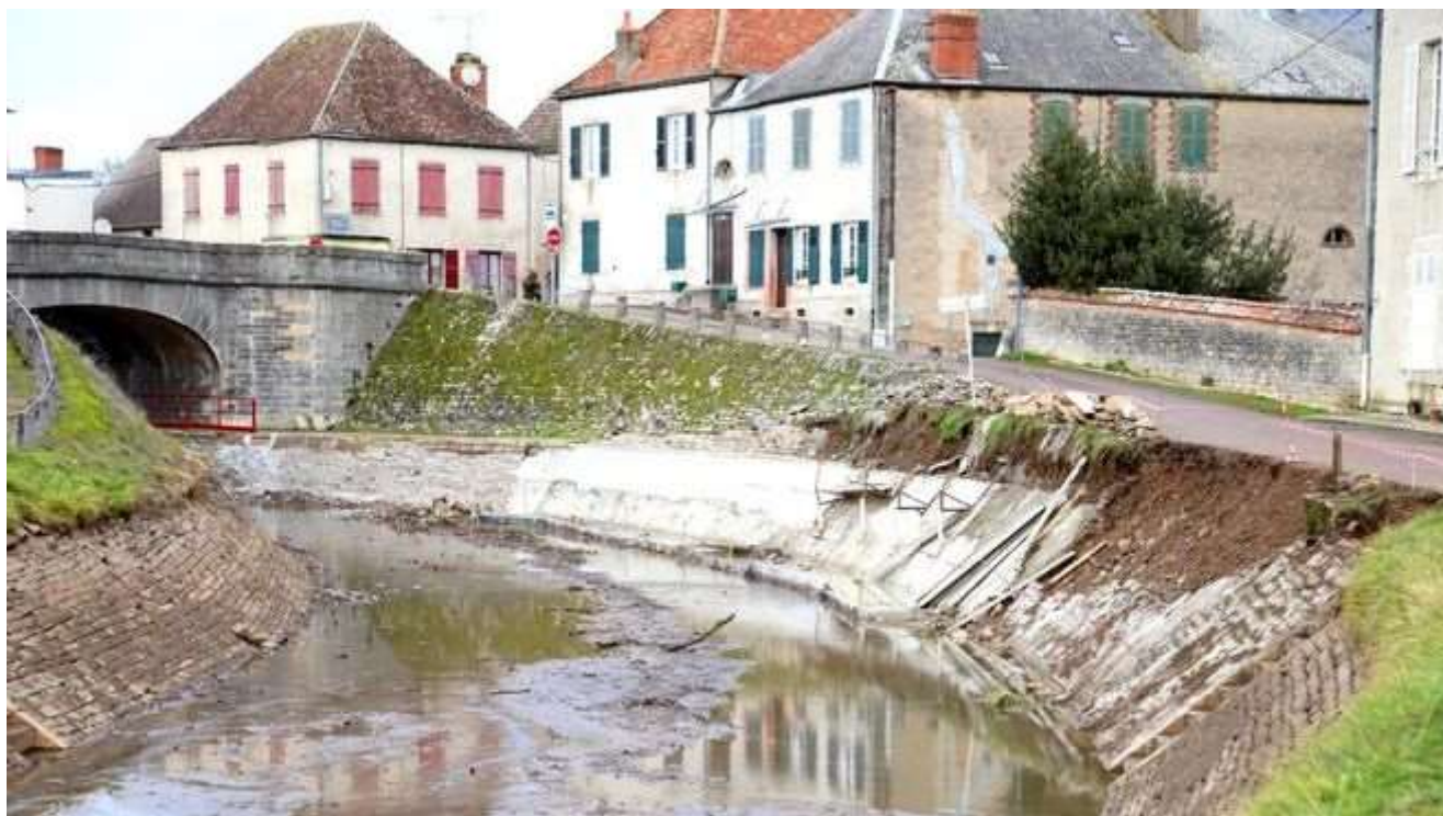
Réfection du perré en amont du pont de Châtillon. © Droits réservés
