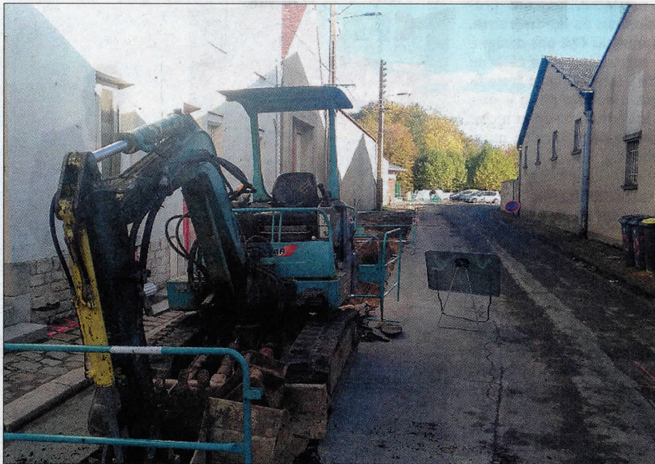
Rue du Port, des tranchées ont été ouvertes pour permettre de dissimuler les réseaux.
