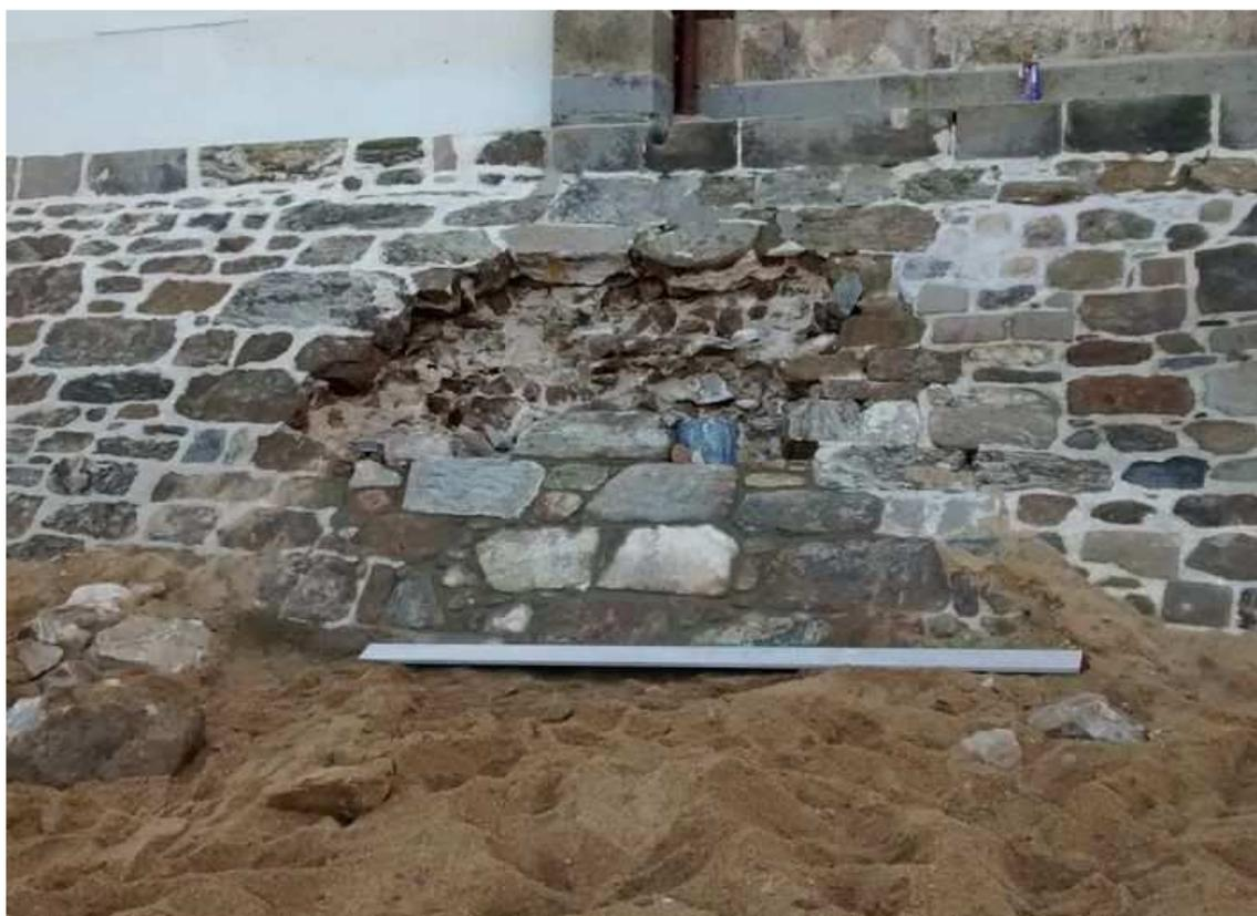
*Dégâts sur un tronçon de la digue Nord de Saint-Malo – Réparations en cours*
